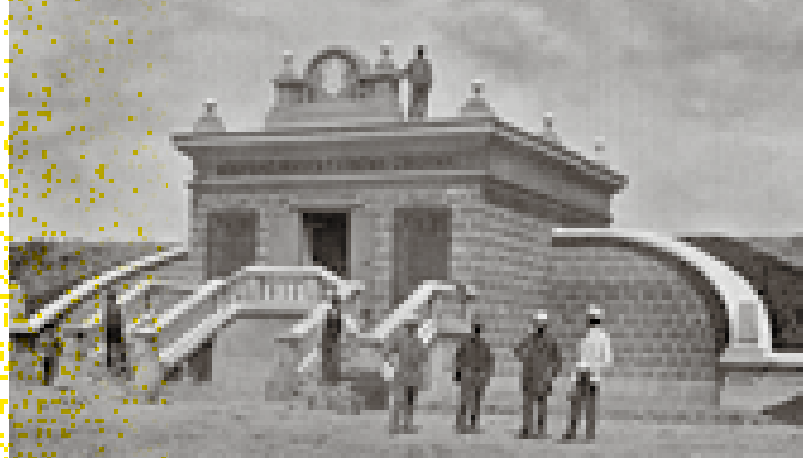
Zbiornik wody w Krzyżu, 1910, z arch. Tarnowskich Wodociągów
